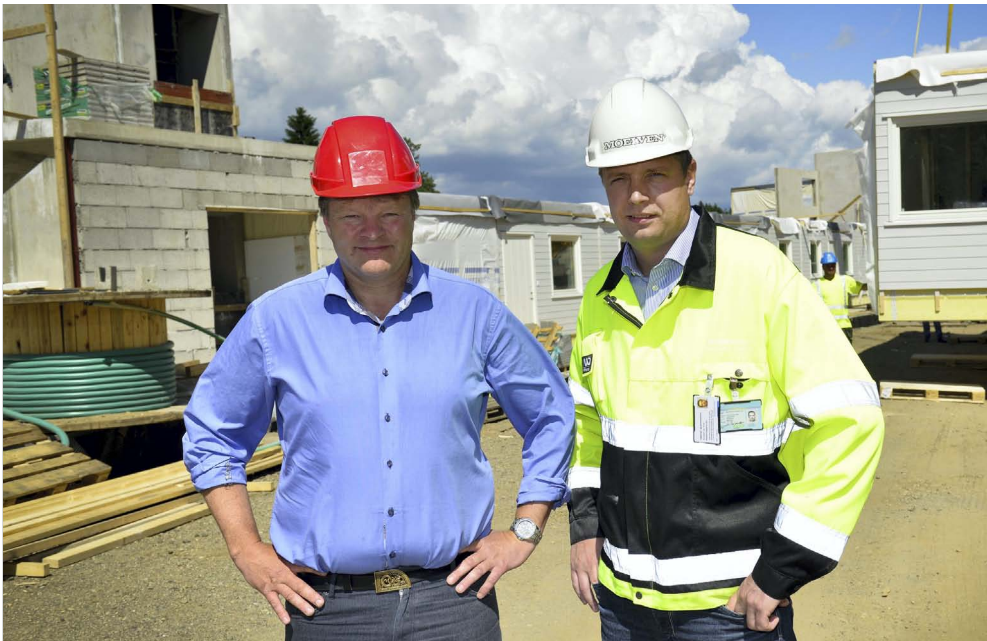
FORNØYDE: Direktør Lars Brede Aandstad (til h.) i Moelven Byggmodul AS selv til stede da modul nr. 80 000 ble heist på plass. Daglig leder Ole Johan Krog Bakke AS er fornøyd med progres-
